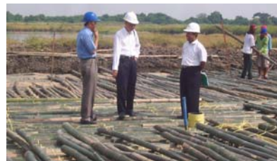
Uji Skala Penuh Untuk Timbunan Jalan
