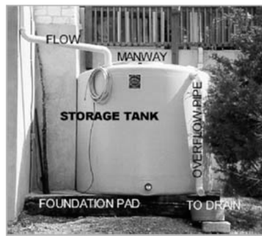
Gambar 6. Tipikal Desain Rencana Instalasi Bak Penyimpanan Air Hujan
